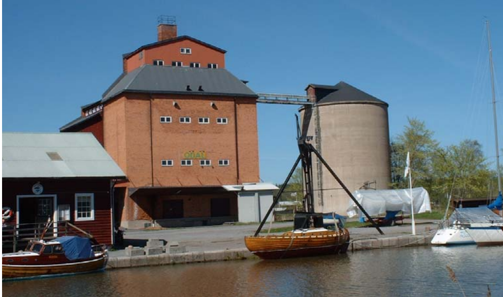
Siloanläggning som revs 2006.
